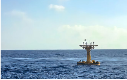
陽江三山島四海上風電項目測風塔
